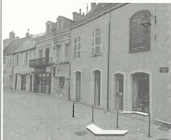
terme n° 8 : 5 rue Helin Lafarge 1 052,83 €/m 2
