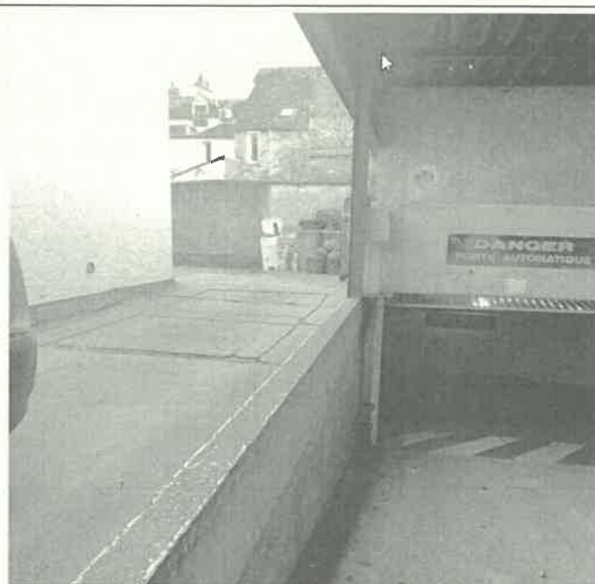
Sortie extérieure local poubelles
